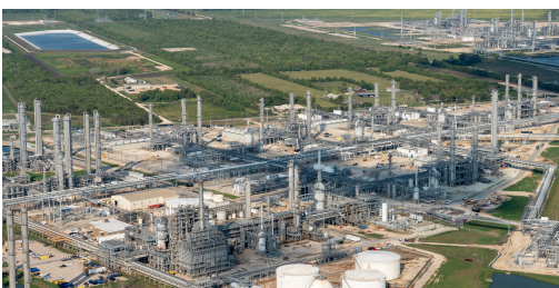
▲LPGの精製設備
